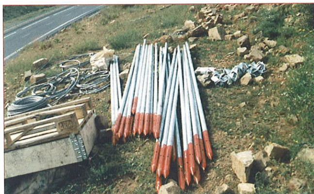
Fig. 16.- Detalle de anclajes especiales para suelos, tipo ATM, instalados en la obra N-V, tramo Almaraz-Jaraicejo, t.m. Miravete (Cáceres).
