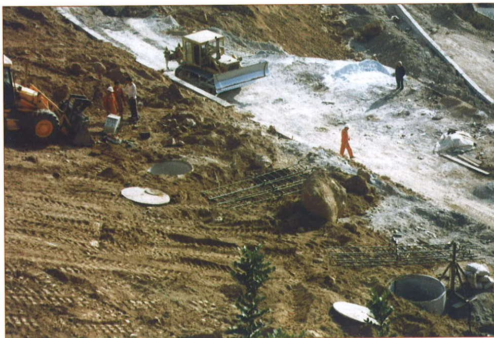
Fig. 15.- Pozos drenantes ejecutados en coronación del muro 2.
