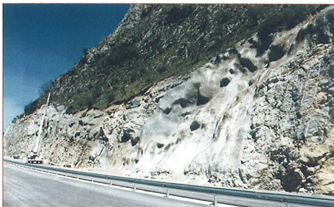
Fig. 19.- Ladera de Azpiroz (Navarra). A-15 Pamplona - S. Sebastian. Talud de desmonte estabilizado mediante gunita con mallazo, bulones, drenes californianos y malla de t.t.; a cotas superiores Pantallas Dinámicas para protección frente a caídas de piedras del resto de la ladera.
