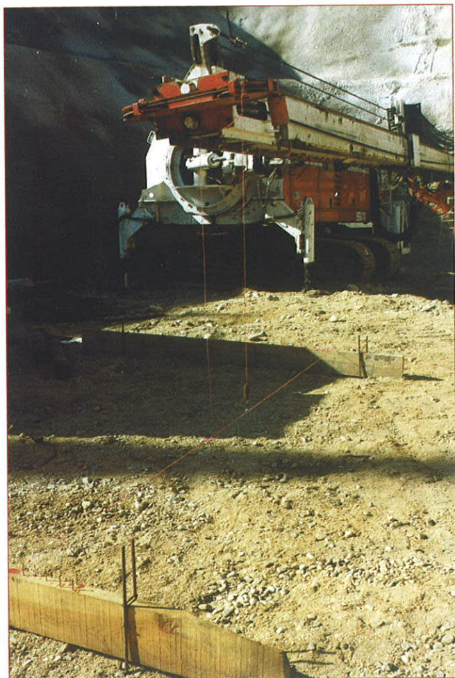
Fig. 4.- Replanteo detrás del equipo de perforación.
