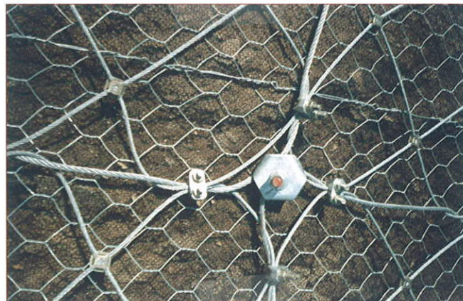
Fig. 7.- Detalle de instalación en zona de unión de paños. Vista placa tipo rana. Obra N-V, Miravete (Cáceres). Aplicación en suelos en combinación con geomalla.
