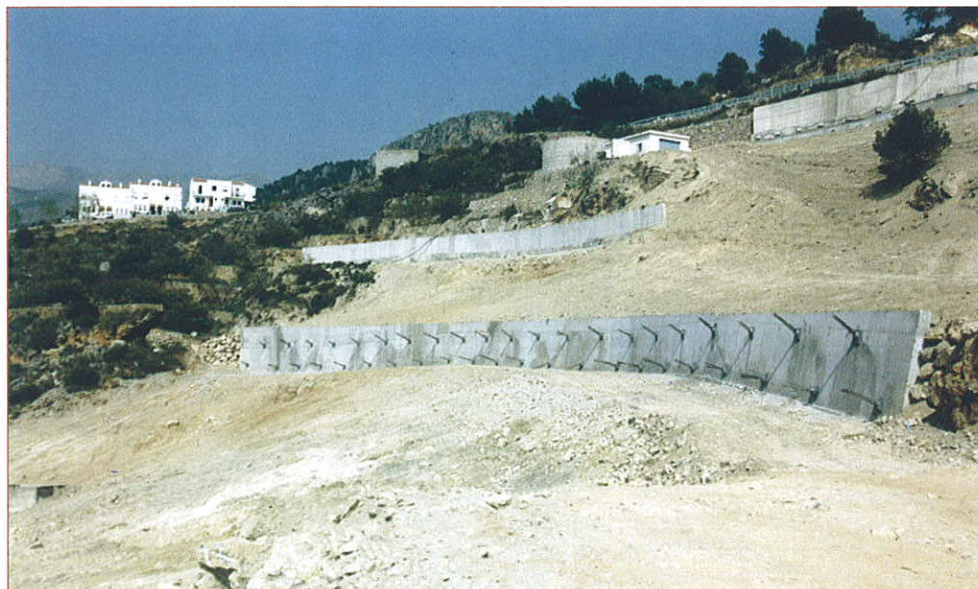
Fig. 12.- Vista general del muro 4 donde se observan los anclajes ejecutados.
