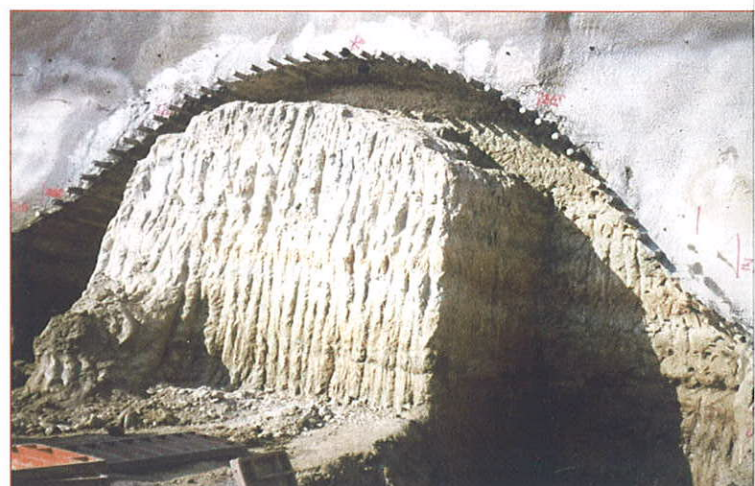
Paraguas terminado y listo para ejecutar viga de atado.
