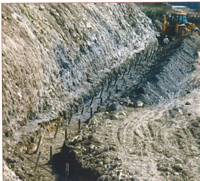
Fig. 11.- Excavación de zapata para soldadura de conectores en muro 3.
