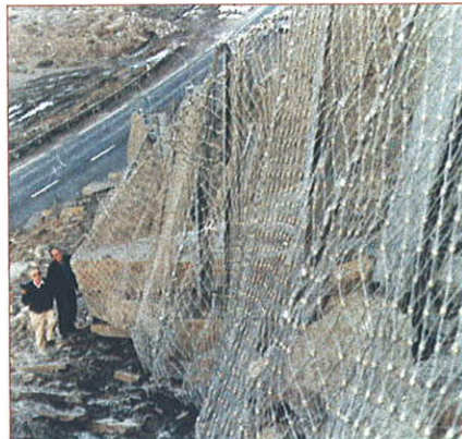
Fig. 9 y 10.- Primera Pantalla Dinámica instalada por TESINSA en 1991. Obra: N-634, entre Getaria y Zumaia (Guipúzcoa), para la Diputación Foral de Guipúzcoa.
