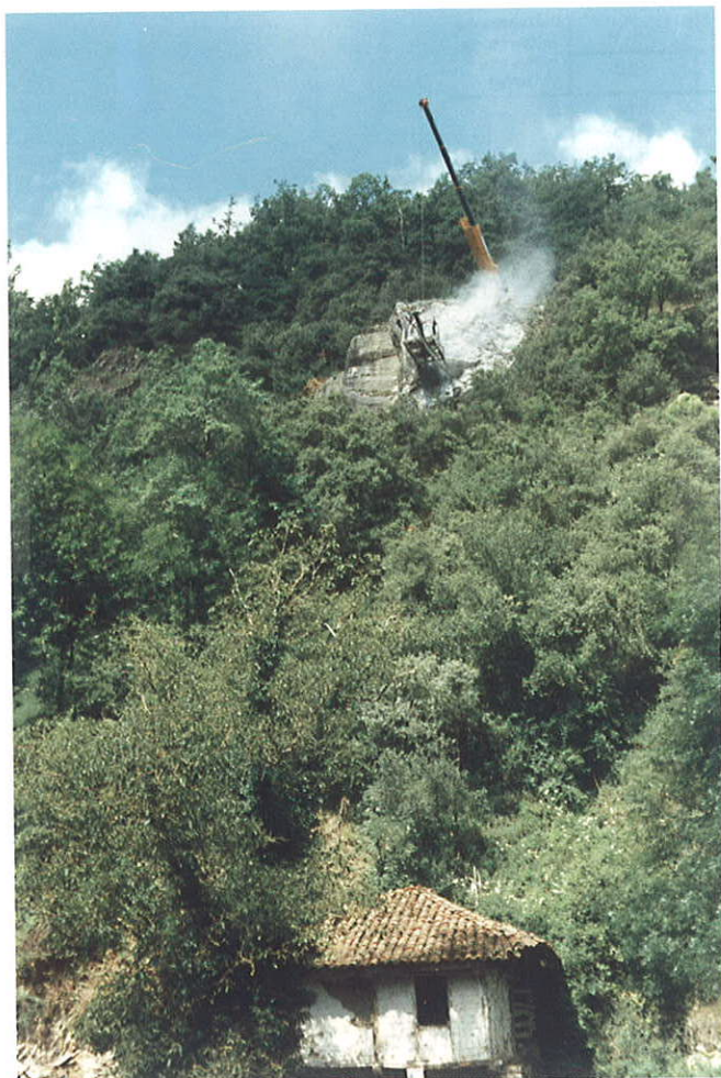
Fig. 28.- Solución especial de atado de bloque, como medida preventiva previa a su bulonado. Camaleño, Cantabria.
