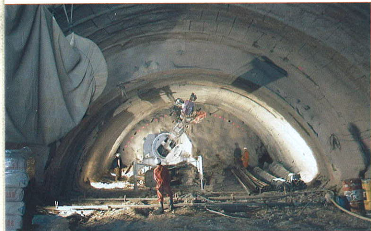
Operación de replanteo del equipo.
