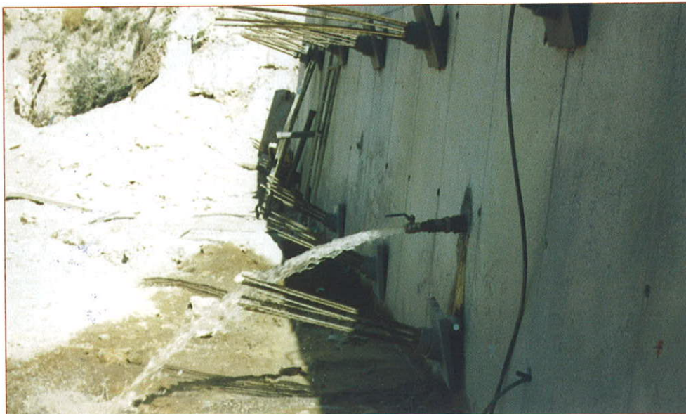
Fig. 14.- Taladro de evacuación de agua en los pozos.
