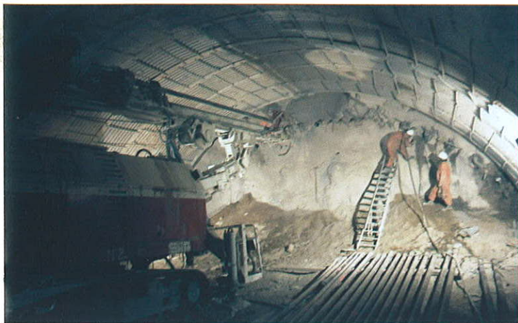
Perforación e inyección de taladros simultáneamente.
