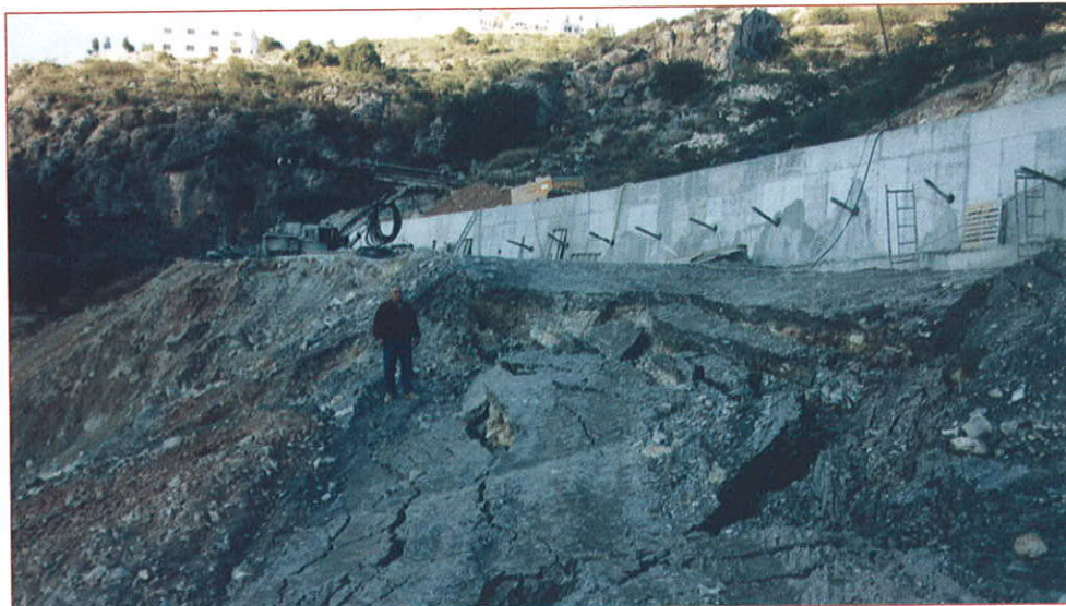
Fig. 18.- Deslizamiento generado en la excavación para ejecución de muros.
