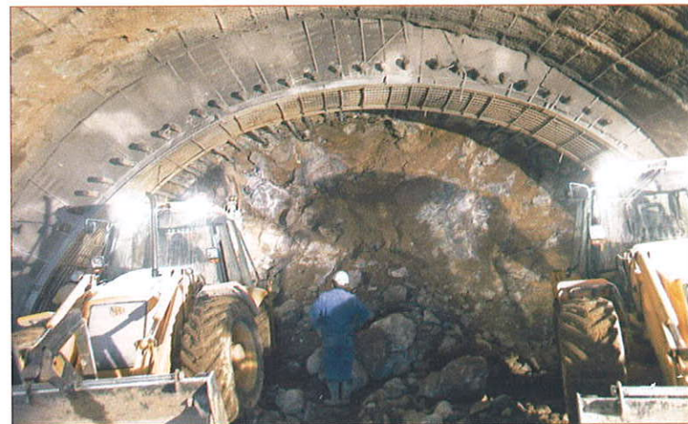
Fig. 15.- Excavación mediante martillos picadores de frente rocoso bajo un paraguas.
