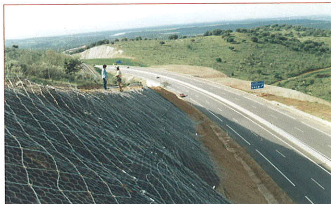
Fig. 15.- Primera instalación como Sistema Pasivo en suelos. 1.996; N-V, tramo Almaraz-Jaraicejo, t.m. Miravete (Cáceres).
