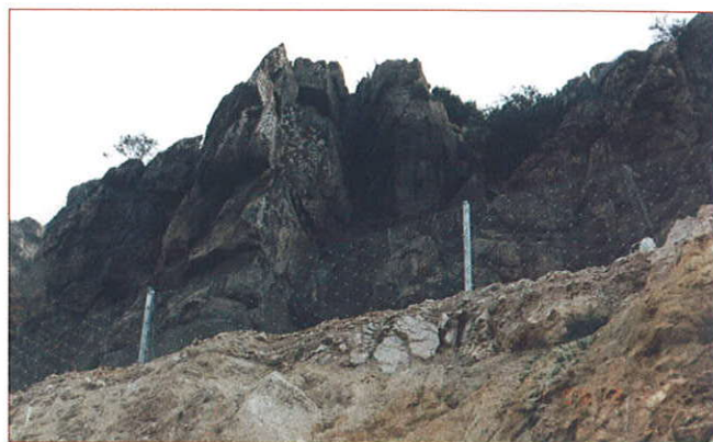
Fig. 20.- Farallón de cuarcitas en boca E túneles de Miravete (Cáceres), N-V. Estabilización con tratamiento puntual bloque a bloque mediante bulonado, gunitado y recalces de hormigón armado en altura. La Barrera Dinámica del pié se colocó como medida preventiva adicional ante la posibilidad (baja, aunque no despreciable) de caídas de bloques no tratados por considerar poco probable su movimiento.
