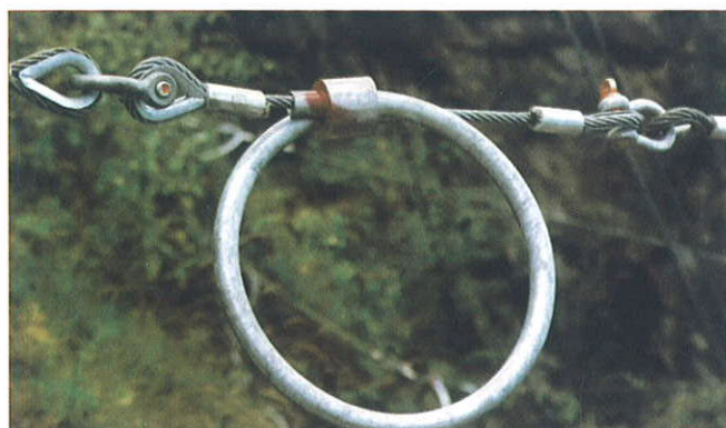
Fig. 23.- Dispositivo de frenado antes y después de la absorción de energía.
