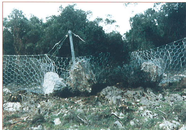
Fig. 1.- Pantalla Dinámica de 750 kJ instalada en una cantera de Vizcaya. Altura paneles 4 m. Los bloques han caído desde una cota 100 m mayor, por una ladera con pendiente media de 45°.
