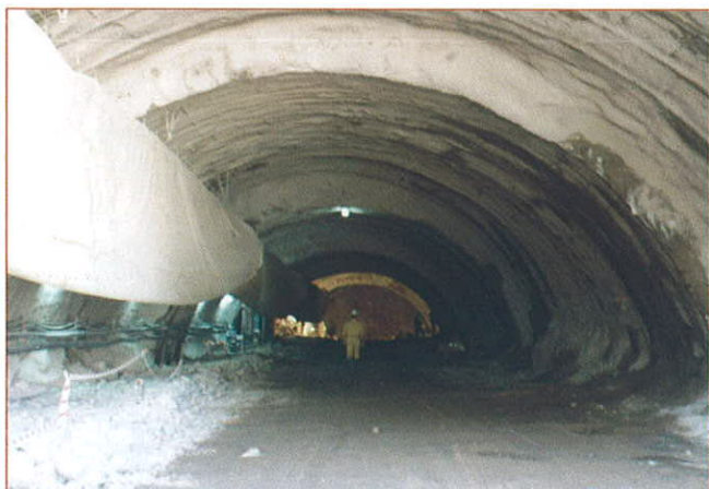
Vista general del sostenimiento con los cinco frentes de emboquille de los paraguas.
