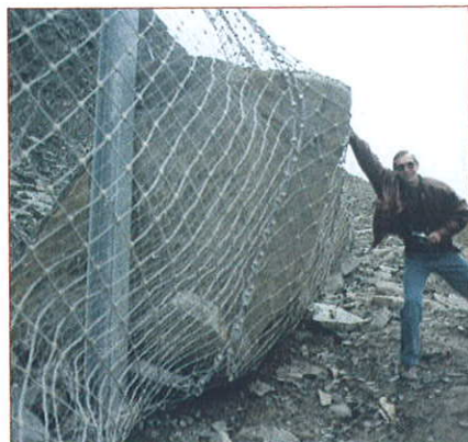
Fig. 9 y 10.- Primera Pantalla Dinámica instalada por TESINSA en 1991. Obra: N-634, entre Getaria y Zumaia (Guipúzcoa), para la Diputación Foral de Guipúzcoa.
