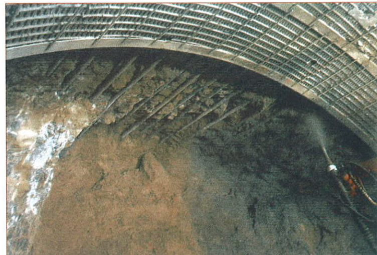
Micropilotes descubiertos en el frente del túnel.
