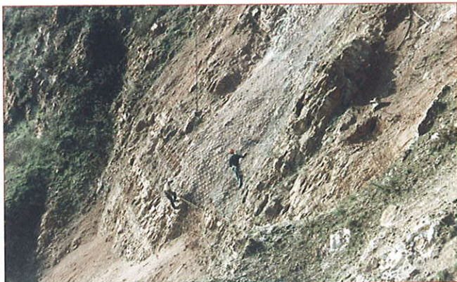
Fig. 14.- Primera instalación como Sistema Pasivo en rocas, con capacidad de soporte calculada como conjunto. Antigua Cantera de cuarcita de Campa Torres, Puerto del Musel, Gijón, 1.995.
