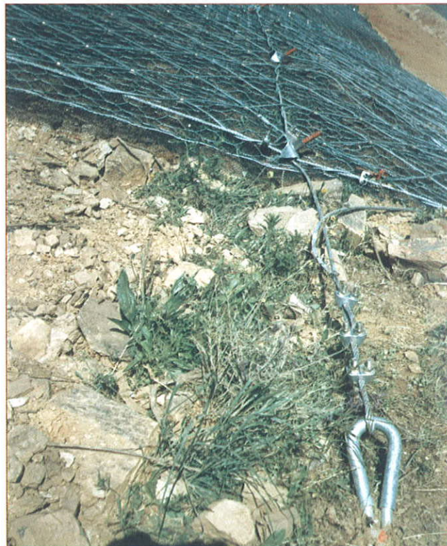
Fig. 8.- Detalle de instalación en zona perimetral. Obra N-V, Miravete (Cáceres).
