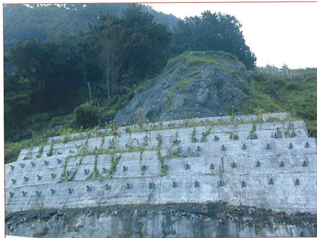
Fig. 21.- N-634, Deba (Guipúzcoa), combinación de Red de Cables activa con estabilización en el pie mediante muro anclado.
