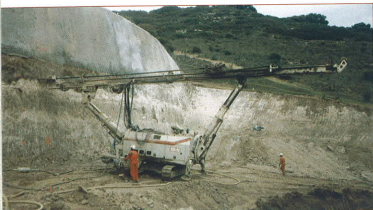
Equipo perforando bulones en talud de emboquille.
