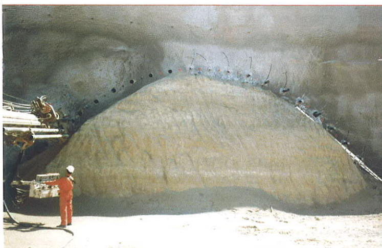
Paraguas de emboquille en ejecución.
