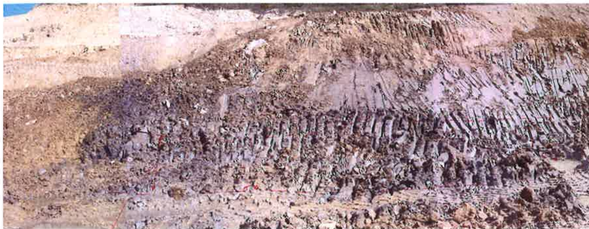
Detalle del plano de deslizamiento secundario del p.k. 7+220
