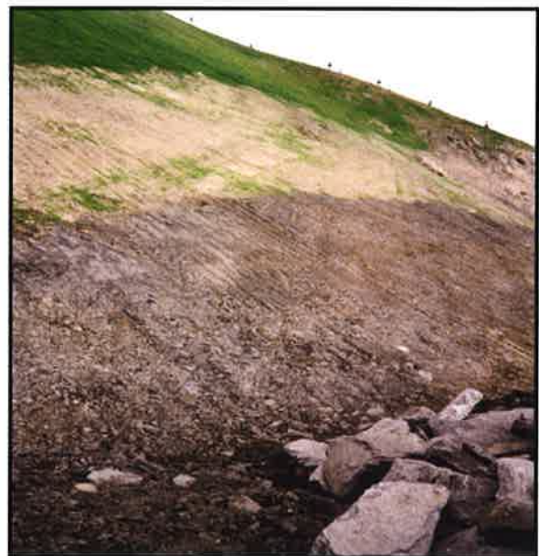
Foto 3. Afloramiento roca con vuelco de estratos
