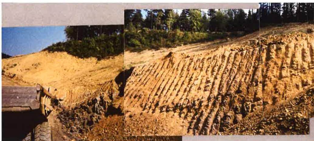
Ver detalle del deslizamiento secundario del p.k. 7+200
