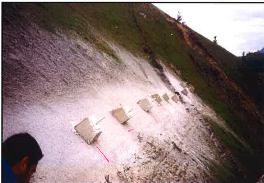
Foto 8. Vista lateral de las grietas con levantamiento de labio inferior una vez iniciadas las obras de sostenimiento
