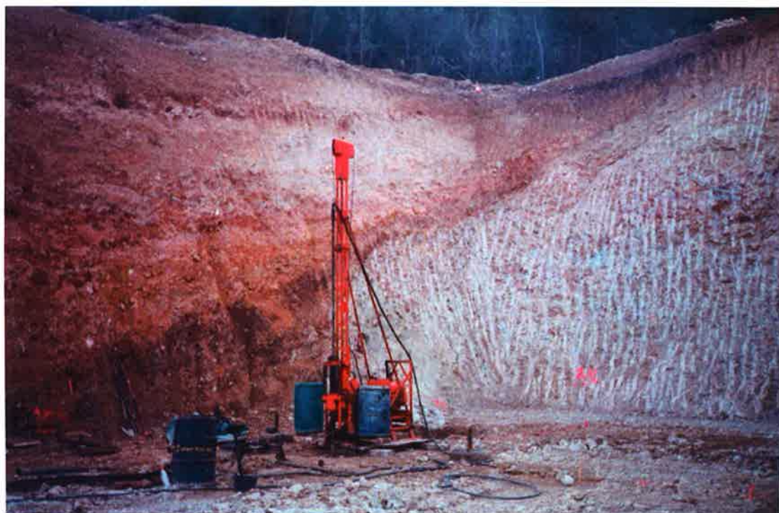
Foto 6. Excavación pila 13 derecha
