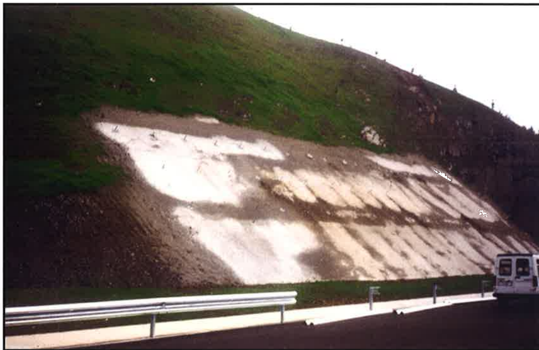
Foto 9. • 3 filas de bulones colocadas
