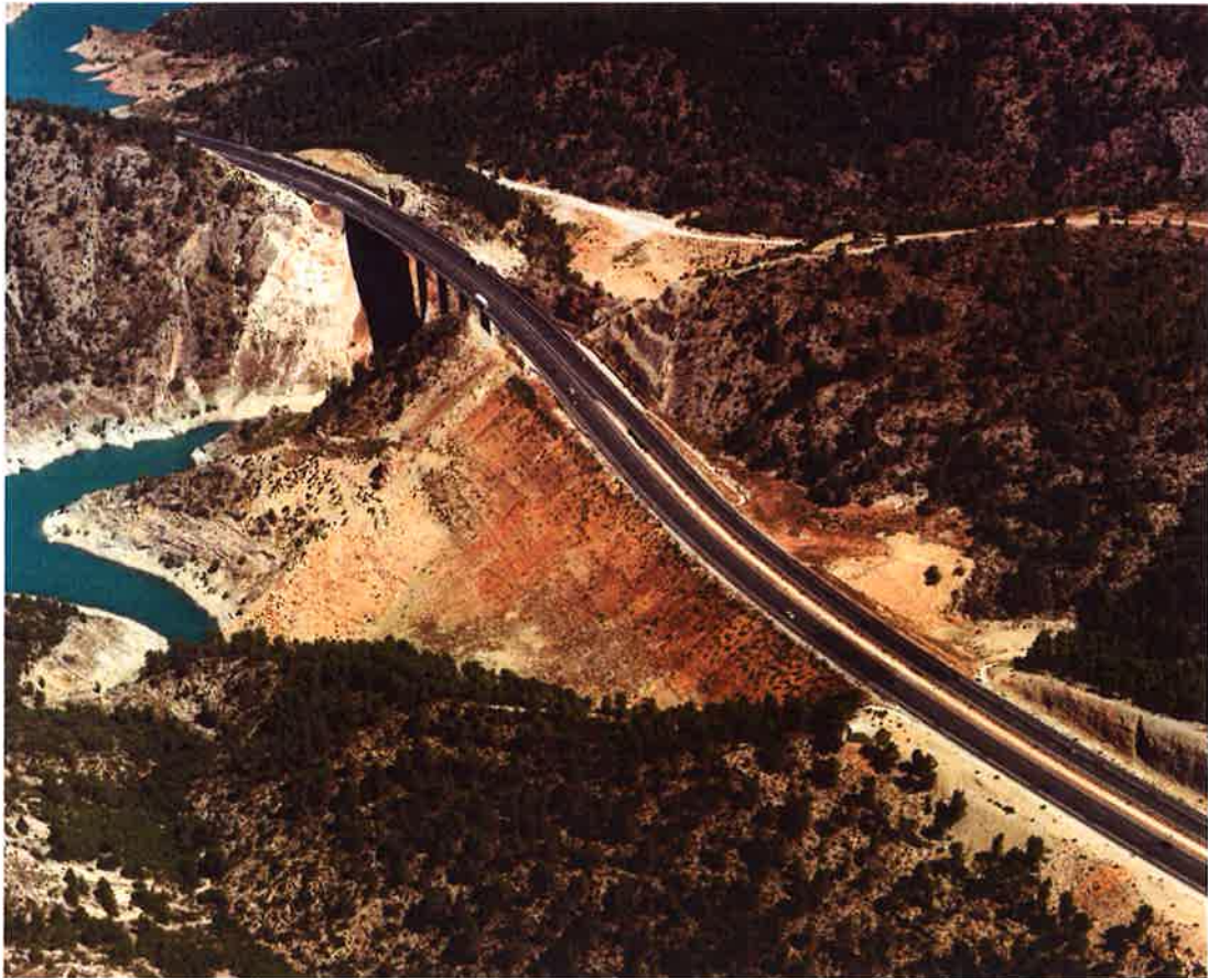
Foto 3. Viaducto del Barranco de la Vid y pedraplén de 100 m de altura
