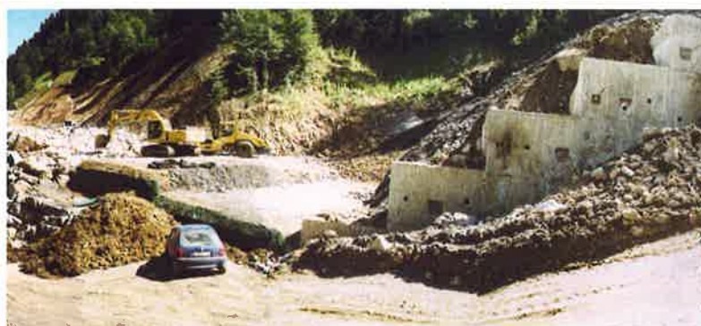
Ejecución muro verde M-7.5 y muro anclado de transición M-7.5-I
