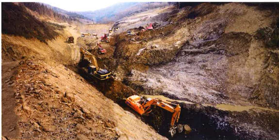
Saneos para el poyo del espaldón en roca sana . Ver detalle del deslizamiento 4.9
