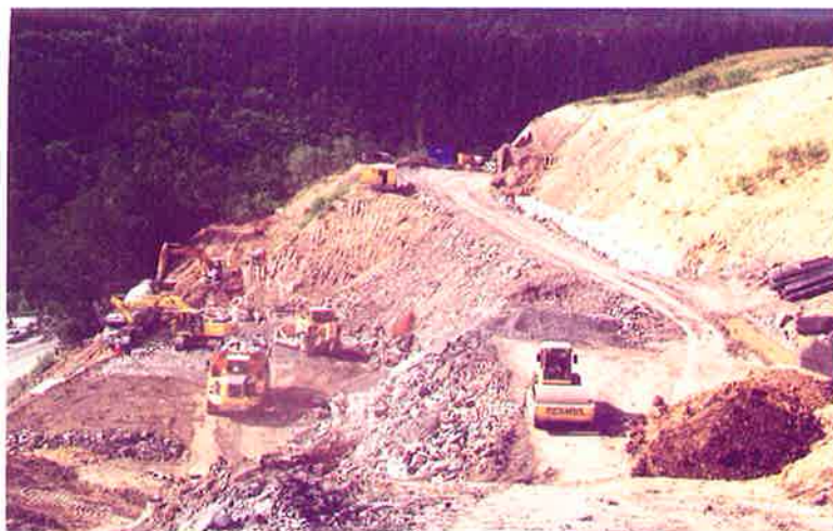
Ejecución muro verde M-7.1 y muro anclado de transición M-7.1-I
