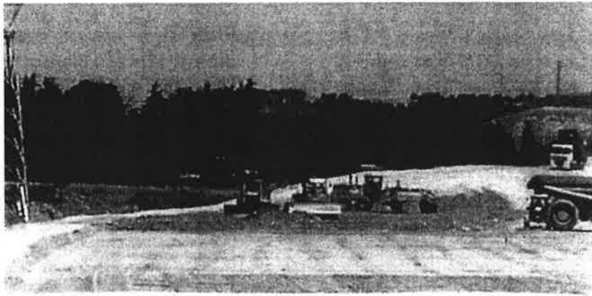
Compactación simultánea del núcleo y del espaldón
