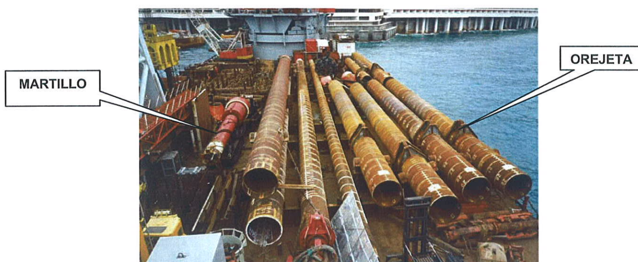
Figura 7: Detalle de pilotes, orejetas y martillo
