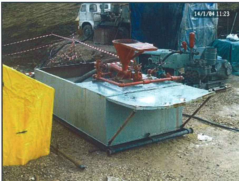
Foto 6.- Balsa de lodos para la estabilización de las paredes del sondeo
