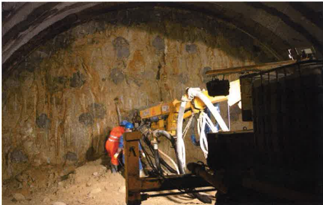
Fotografía n°20: Vista del frente durante la fase de avance, con los taladros de jet perfectamente marcados.
