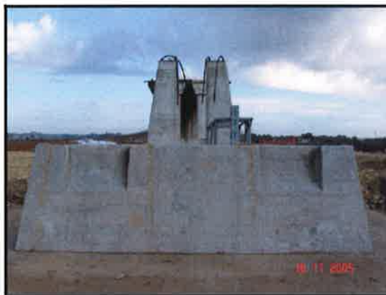
Foto 11. Plinto de apoyo de semiarcos. En la parte superior se observan los huecos en los que se materializa la rótula.
