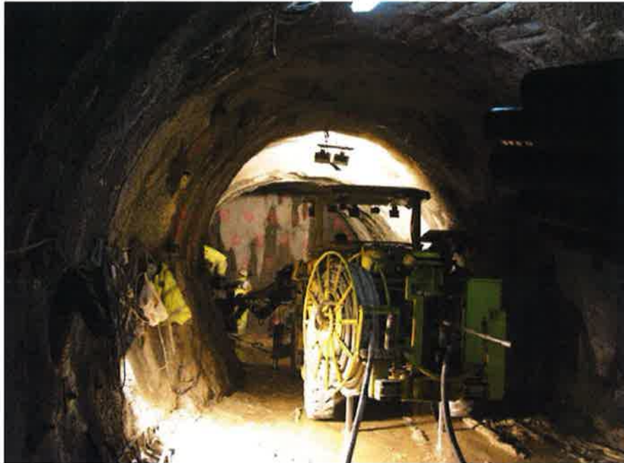
Fotografía n°14: Obsérvese como el hastial izquierdo se ha desplazado más de 90 cm debido a la presión ejercida por una bolsa de jabre, hasta que éste encuentra salida para liberar su presión.
