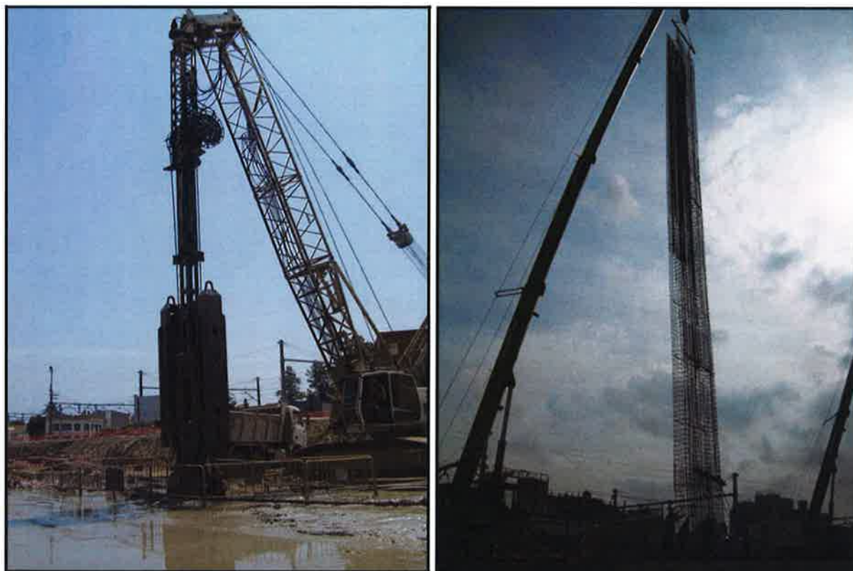
Foto 1 y 2: Excavación con cuchara convencional e introducción de jaula de armadura en el batache.
