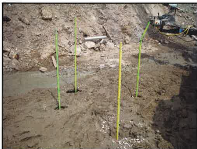
Foto 21 y 22: Preparación para la realización del taladro con la maquinaria de Jet Grouting y ejecución de la perforación de Jet Grouting.
