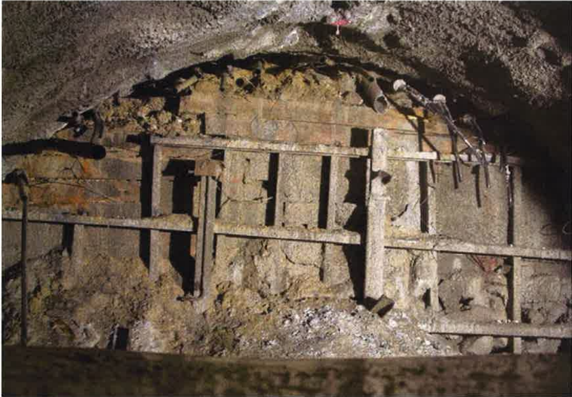
Fotografía n°7: colocación de tape en zona de campana para relleno con hormigón antes de reanudar el avance.
