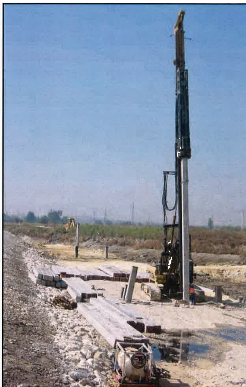
Foto 3. Hincia de pilotes prefabricados.
