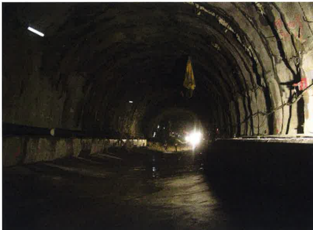
Fotografía n°25: Vista del túnel tras la ejecución de la contrabóveda y de los muros guía para el revestimientos.
