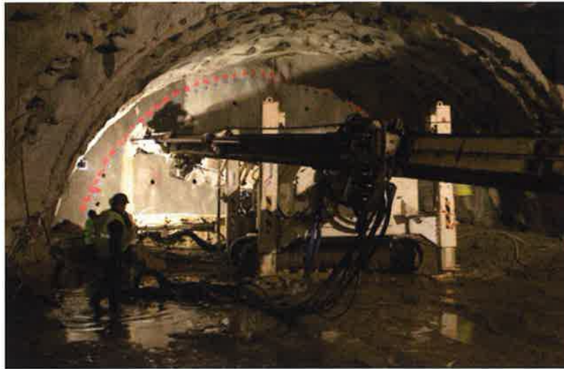
Fotografía n°19: Ejecución de la pantalla perimetral secante de jet-grouting.
