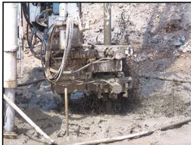
Foto 21 y 22: Preparación para la realización del taladro con la maquinaria de Jet Grouting y ejecución de la perforación de Jet Grouting.
