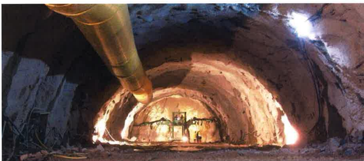
Fotografía n°16: Excavación del túnel de Burata con perforación y voladura en P.K. 5+600 tras pasar la zona de jabre inicial.
