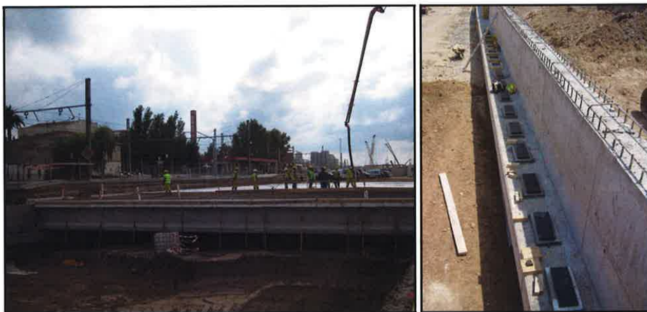
Foto 5 y 6: Colocación de cubiertas del falso túnel. Vista de apoyos de cubiertas prefabricadas.
