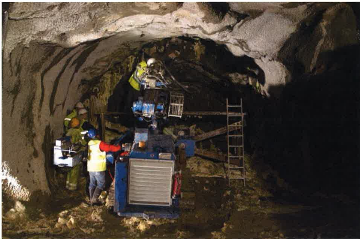
Fotografía nº10: Perforación de taladros de consolidación para ser inyectados con microcementos y tubo manguito.
