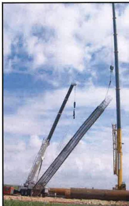
Foto 15. Izado de un tramo de armadura para un pilote de diámetro 2000 mm.
