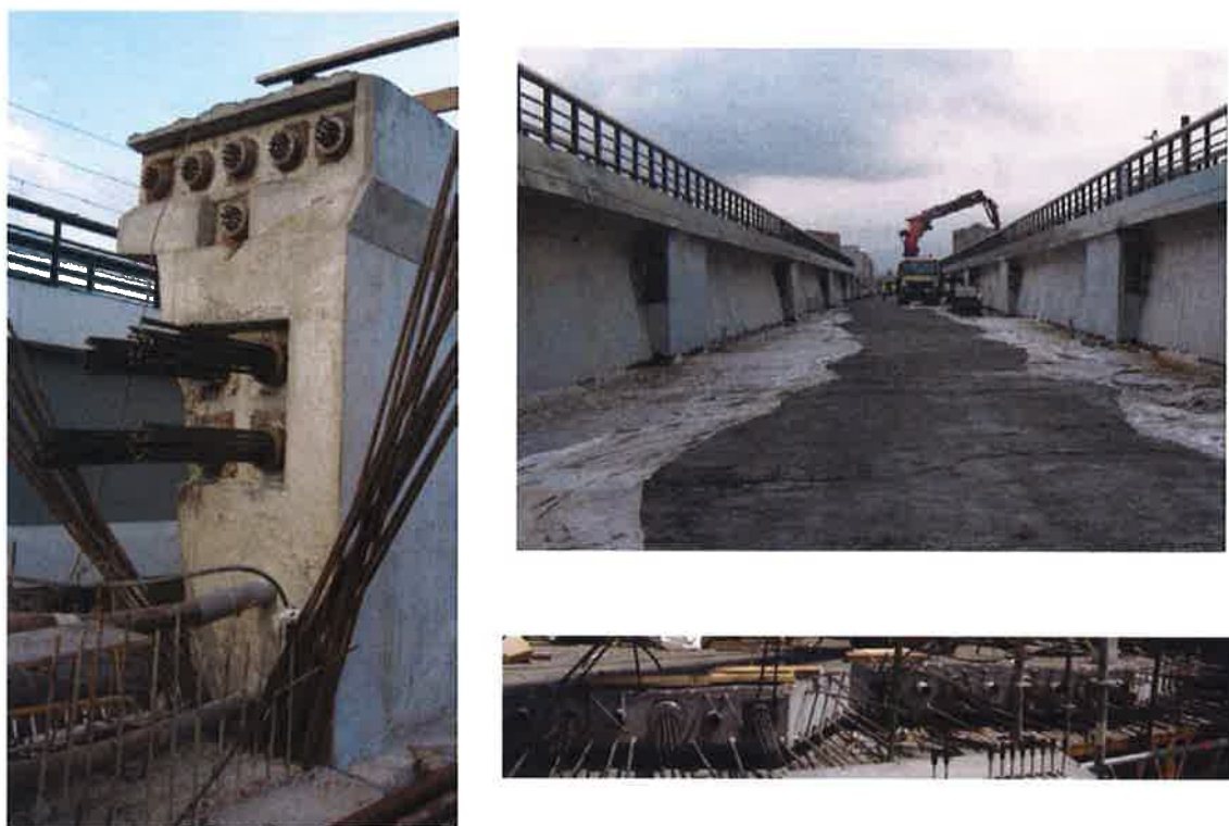
Foto 26. Tipologías de pretensado longitudinal.(zq.: Empuje superior y de servicio en hastial sobre estribo; Dch. Arriba: refuerzo en hastiales sobre pilas y de servicio; Dch. Abajo: Empuje inferior)
