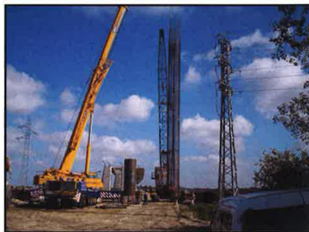
Foto 9 y 10. Excavación de un pilote y colocación de camisas para soldar y de armadura.
