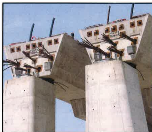
Foto 13. Montaje de viga exterior, se pueden observar las ventanas en la parte inferior de la viga para enhebrar las esperas del arco. En la foto de la derecha se observa el postesado que lleva la viga, con los torones enfilados.
