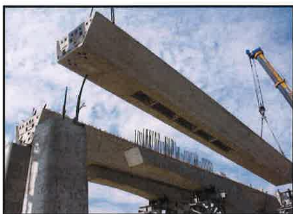
Foto 13. Montaje de viga exterior, se pueden observar las ventanas en la parte inferior de la viga para enhebrar las esperas del arco. En la foto de la derecha se observa el postesado que lleva la viga, con los torones enfilados.
