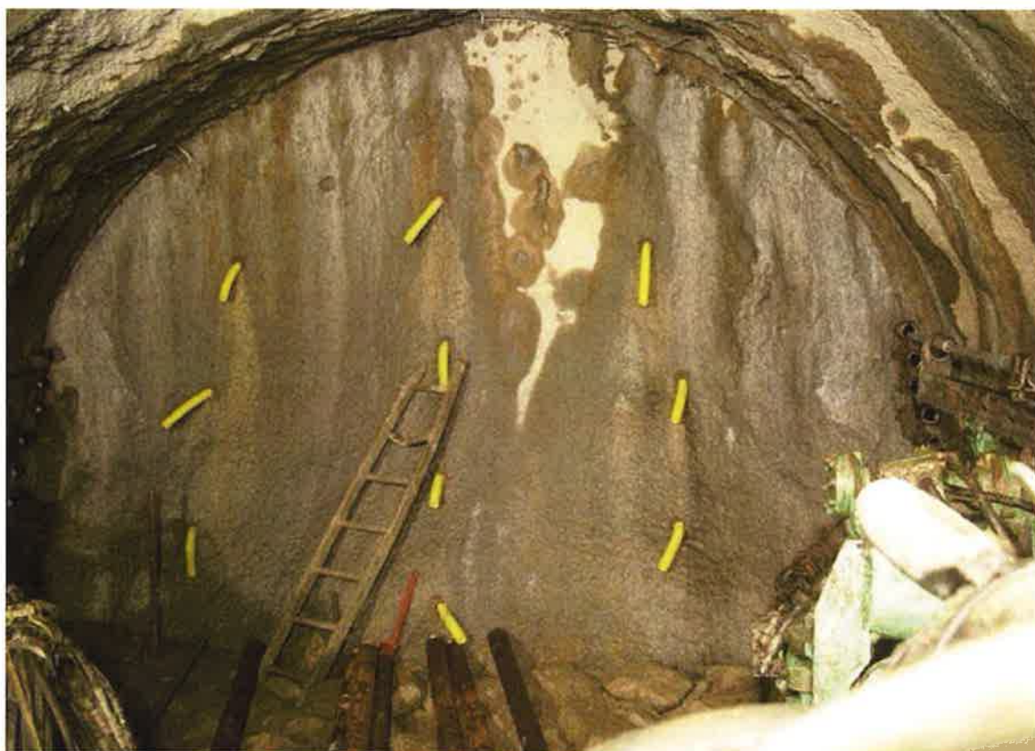
Fotografía n°8: perforación de micropilotes perimetrales y colocación de drenes en frente.
