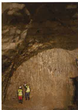
Fotografía n°17: Formación de cuña en clave por confluencia de familias de diaclasas.
