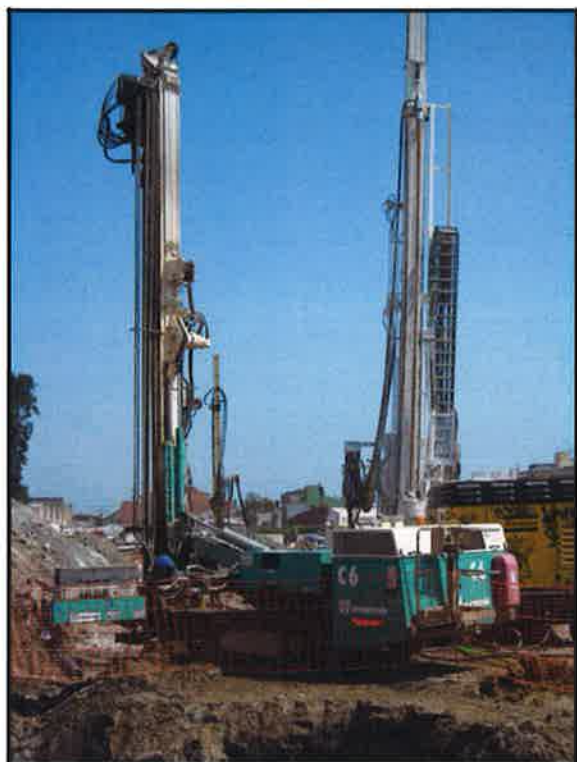
Foto 19 y 20: Máquina para la ejecución del Jet Grouting y ubicación de la máquina en la Obra.
