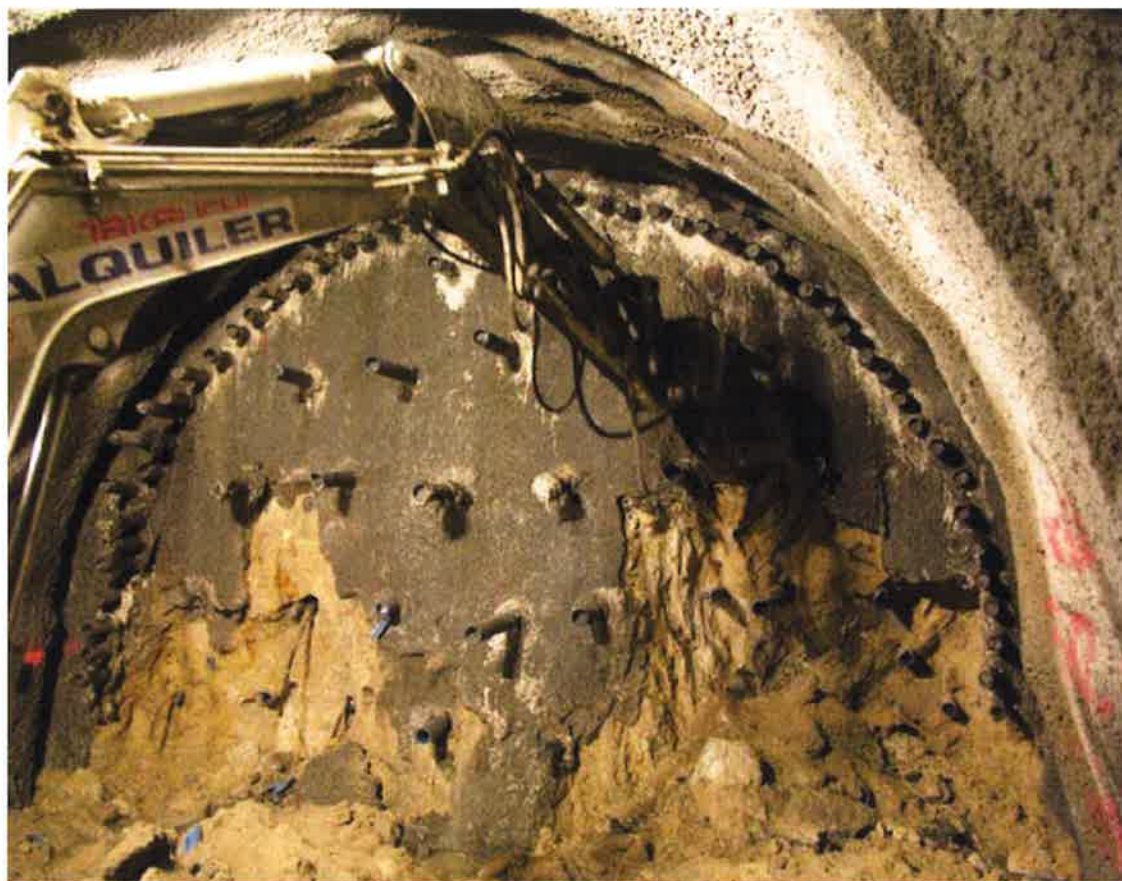
Fotografía nº13: Detalle de reanudación de la excavación tras haberse finalizado el tratamiento del frente y colocado el paraguas de protección.
