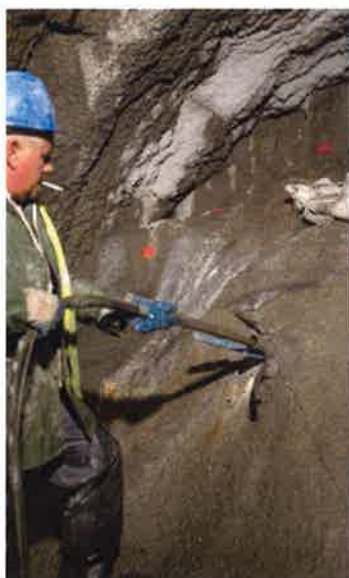
Fotografía nº10: Perforación de taladros de consolidación para ser inyectados con microcementos y tubo manguito.
