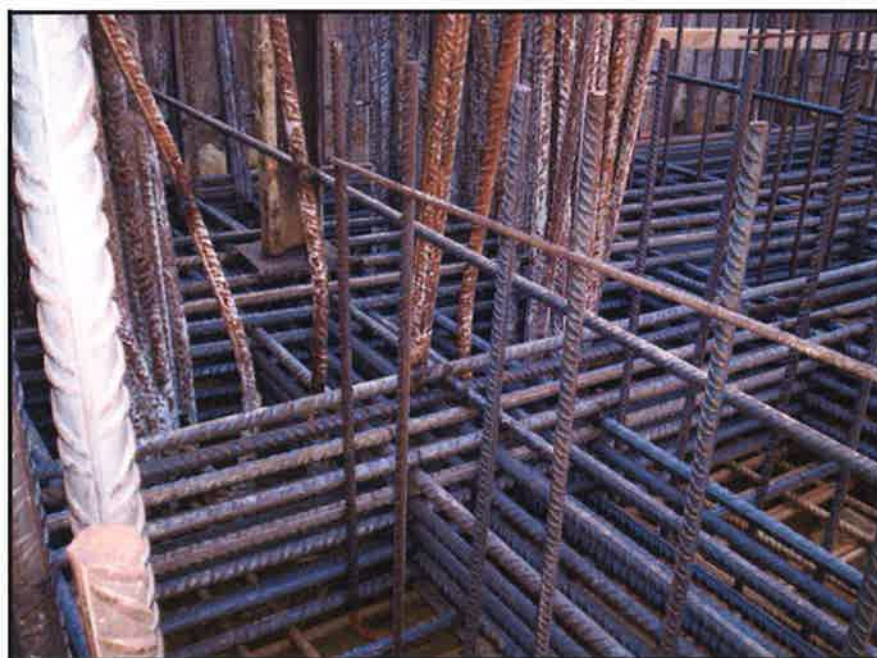
Foto 18. Detalle de armado de la parrilla inferior de un encepado de una pila hiperestática.
