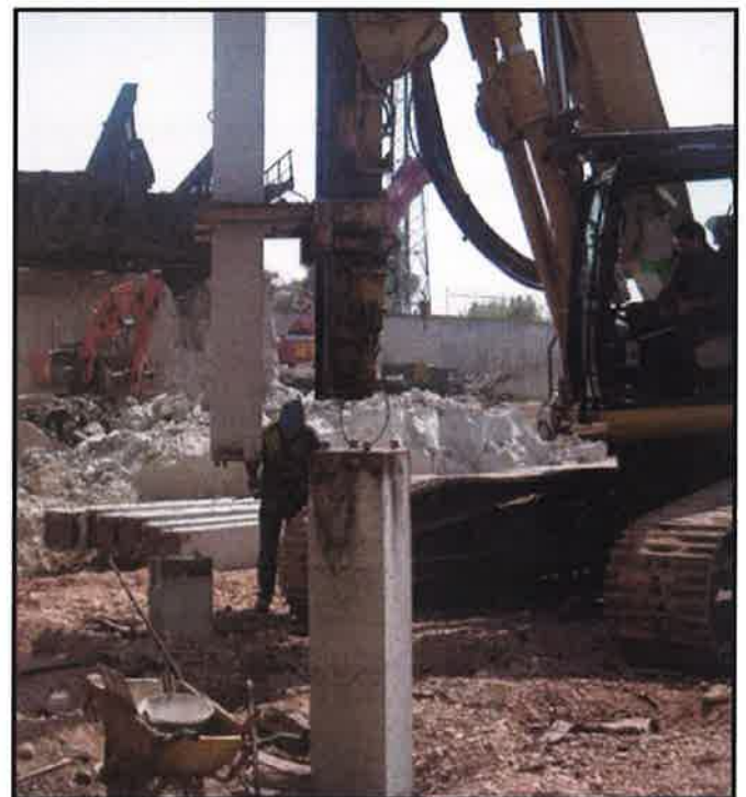
Foto 28. Maquinaria hincado pilotes prefabricados.
