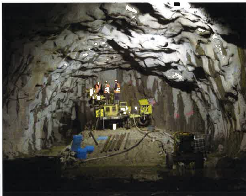
Fotografía n°18: Ejecución de los sondeos horizontales en el frente de excavación antes de P.K. 5+520 y ejecución de drenes largos.
