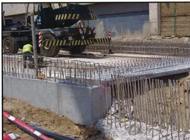
Foto 4: Ejecución de vigas de atado de las pantallas.
