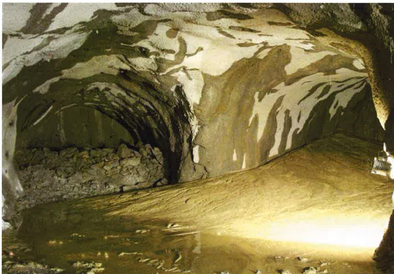
Fotografía n°9: Irrupción de bolsas de jabre a través de los taladros de drenaje. En la fotografía puede verse el entronque, con el frente de la galería de emergencia a la izquierda, y la galería de comunicación con el túnel a la derecha.
