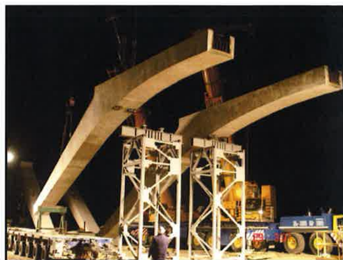
Foto 12. Colocación de semiarco prefabricado. Se pueden observar las torretas metálicas provisionales y al fondo los caballetes guía de apoyo en las rótulas.
