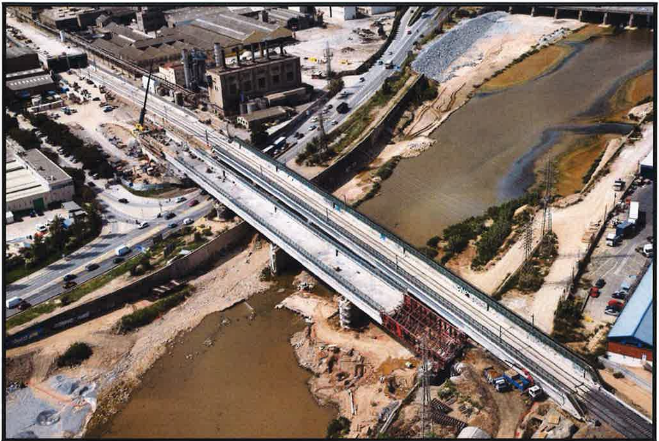
Foto 39. Empuje del tablero, llegando al estribo E-2.
