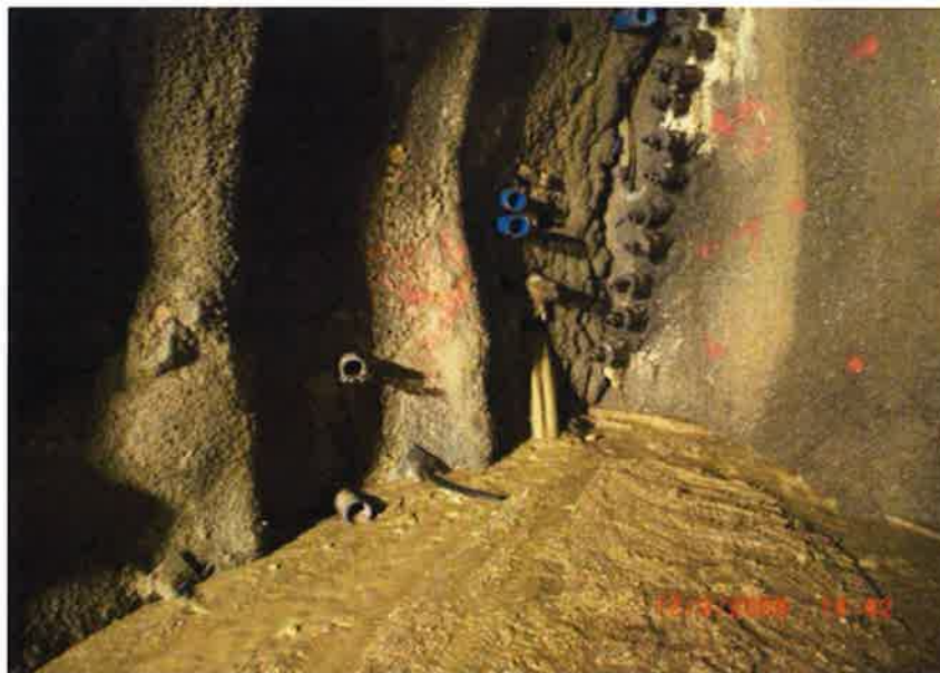
Fotografía n°15: Detalle de taladros con tubos de PVC descargando bolsas de jabre saturadas de agua.
