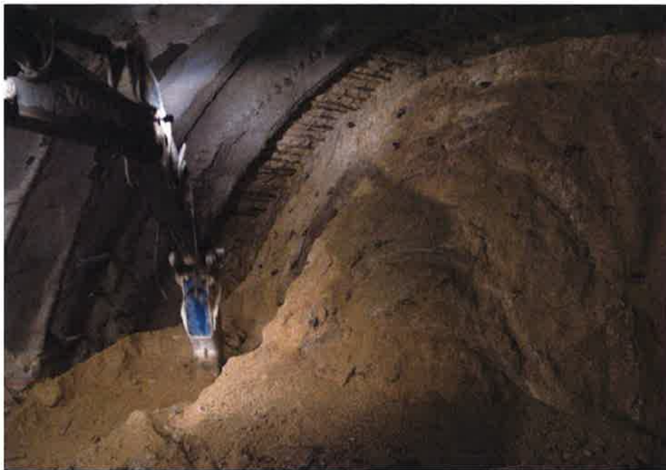
Fotografía n°21: Vista del frente en la fase de avance, con los taladros de micropilotes y de tubos de PVC marcados, y en azul los destinados a drenaje.
