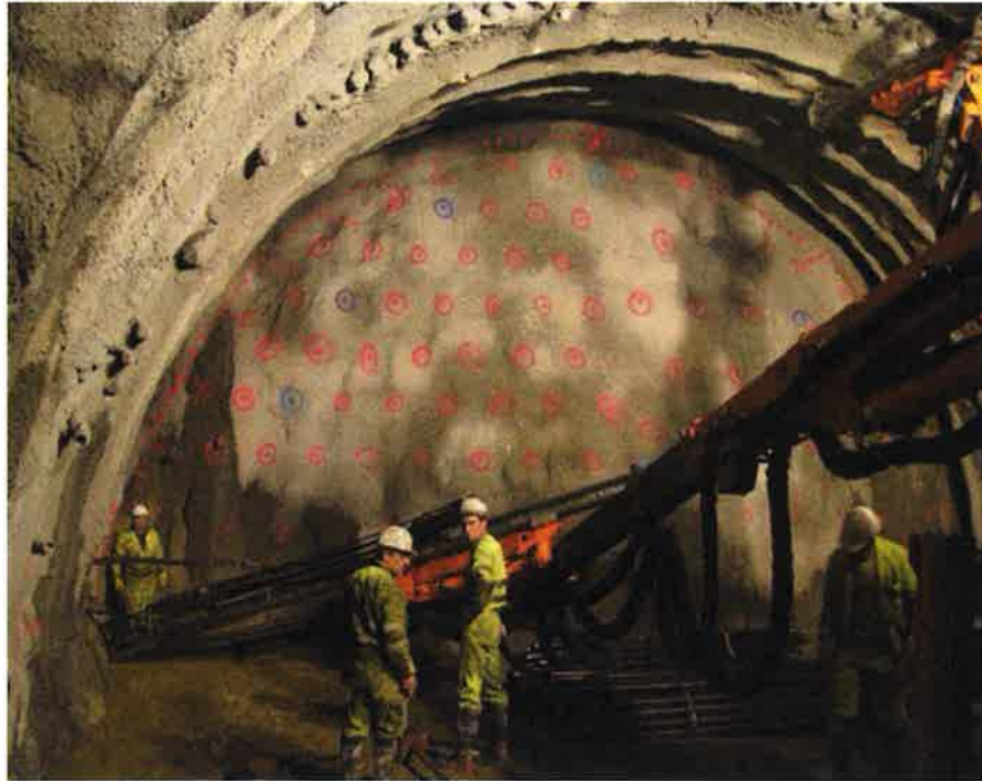
Fotografía n°21: Vista del frente en la fase de avance, con los taladros de micropilotes y de tubos de PVC marcados, y en azul los destinados a drenaje.
