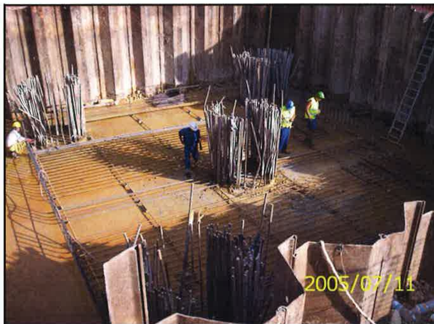
Foto 17. Recinto de tablestacas para un encepado y comienzo de montaje de armadura.
