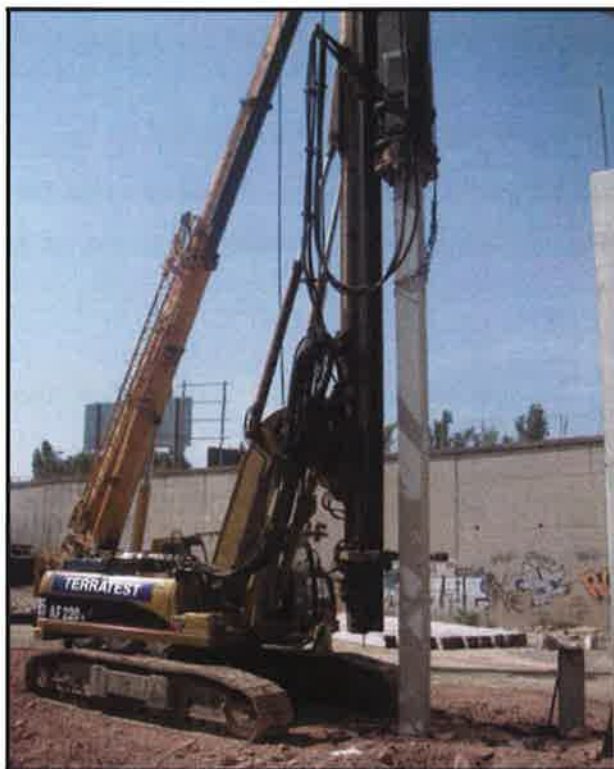
Foto 28. Maquinaria hincado pilotes prefabricados.
