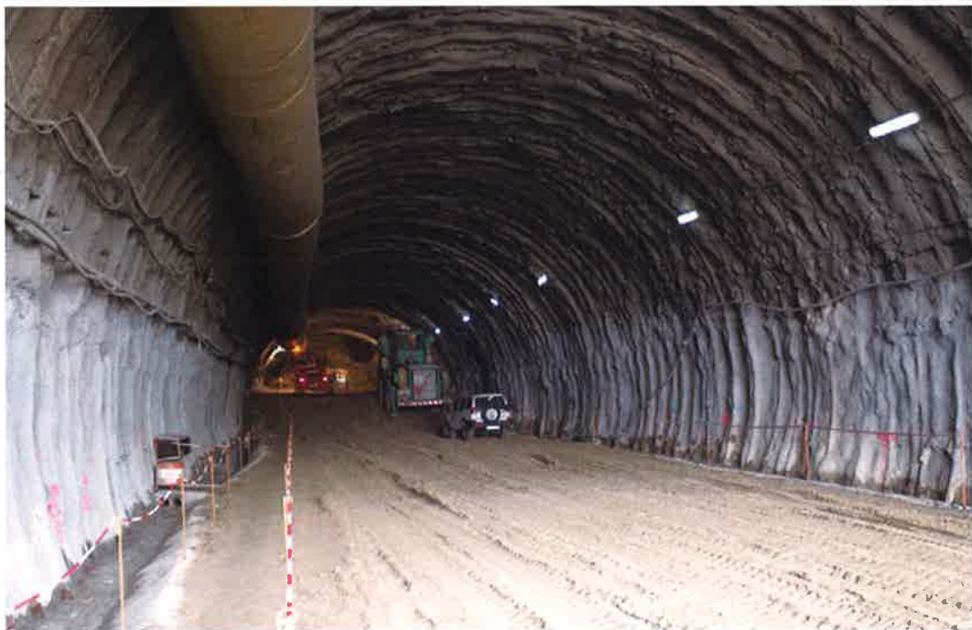
Fotografía nº24: Aspecto del túnel tras la excavación de la destroza.
