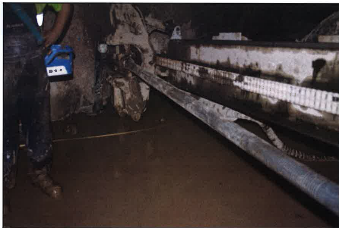
Foto 24. Detalle de la ejecución de drenes horizontales
