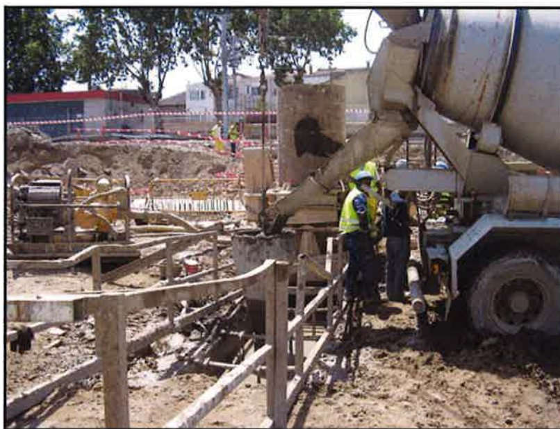
Foto 3: Hormigonado de batache.
