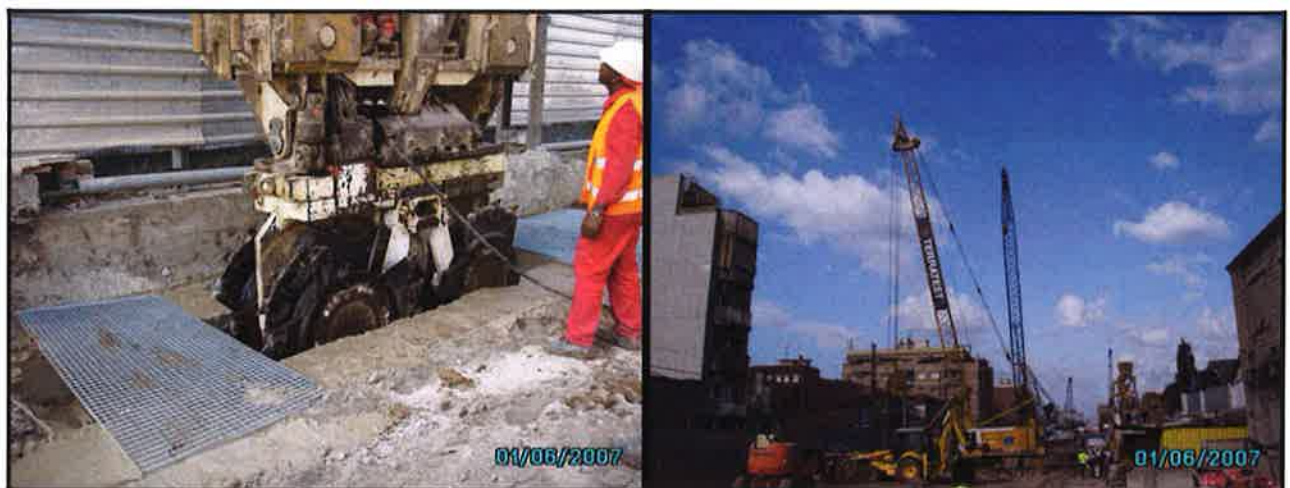
Foto 12 y 13: Ejecución de las obras mediante hidrofresa.
