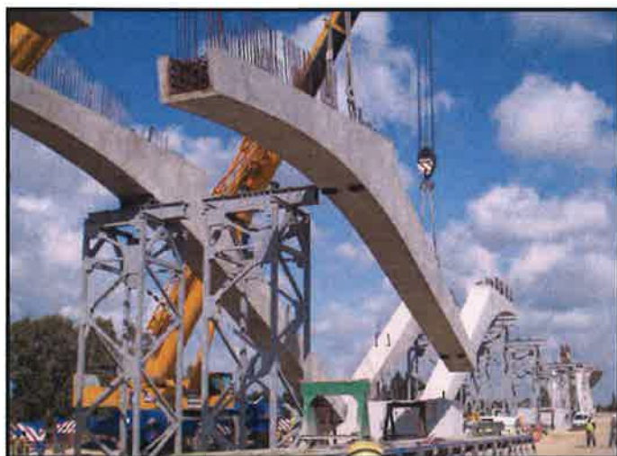
Foto 12. Colocación de semiarco prefabricado. Se pueden observar las torretas metálicas provisionales y al fondo los caballetes guía de apoyo en las rótulas.
