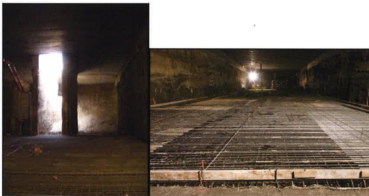
Foto 8 y 9: Ferrallado de la solera del falso túnel.
