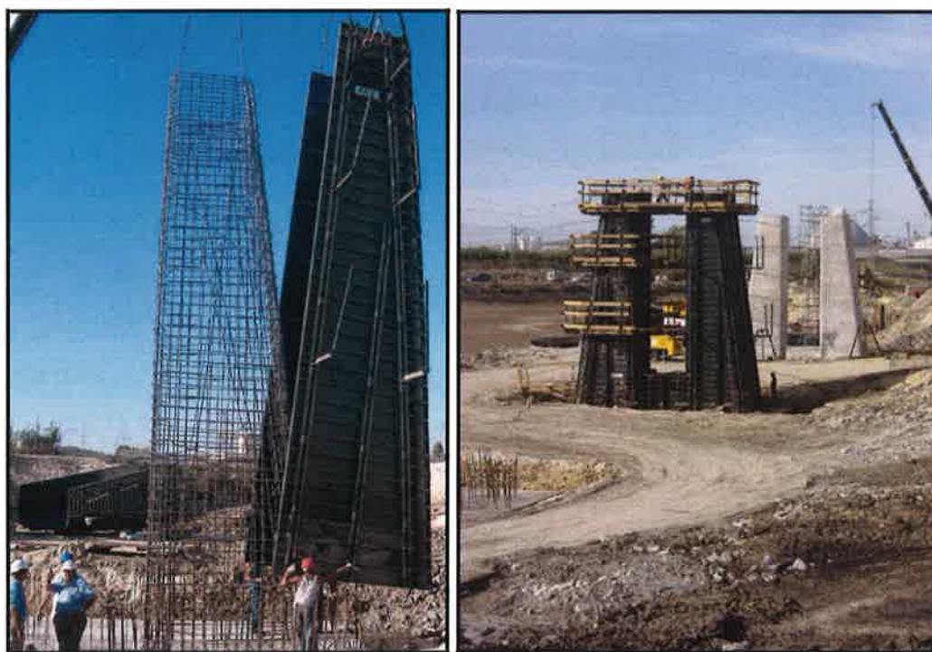
Foto 5 y 6. Ferrallado y encofrado de pilas isostáticas.
