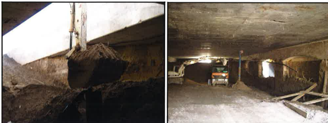
Foto 6 y 7: Excavación del falso túnel.
