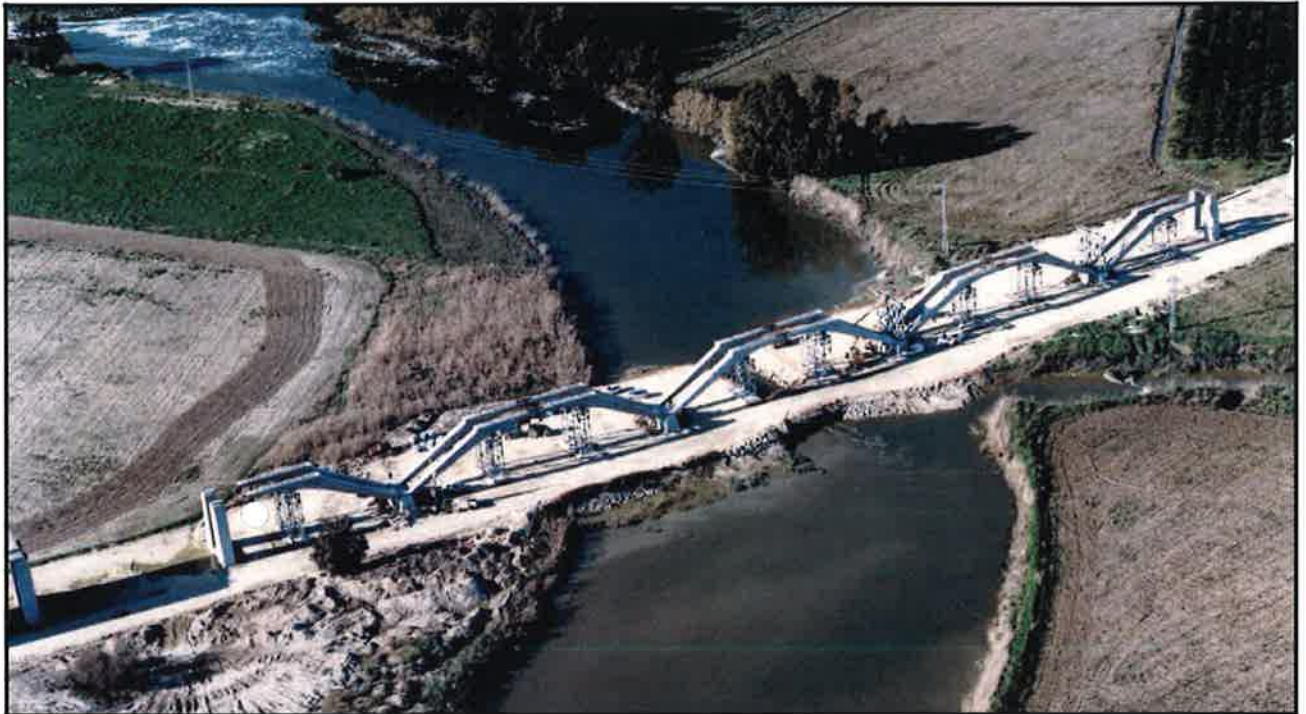
Foto 8. Montaje de los arcos prefabricados.
