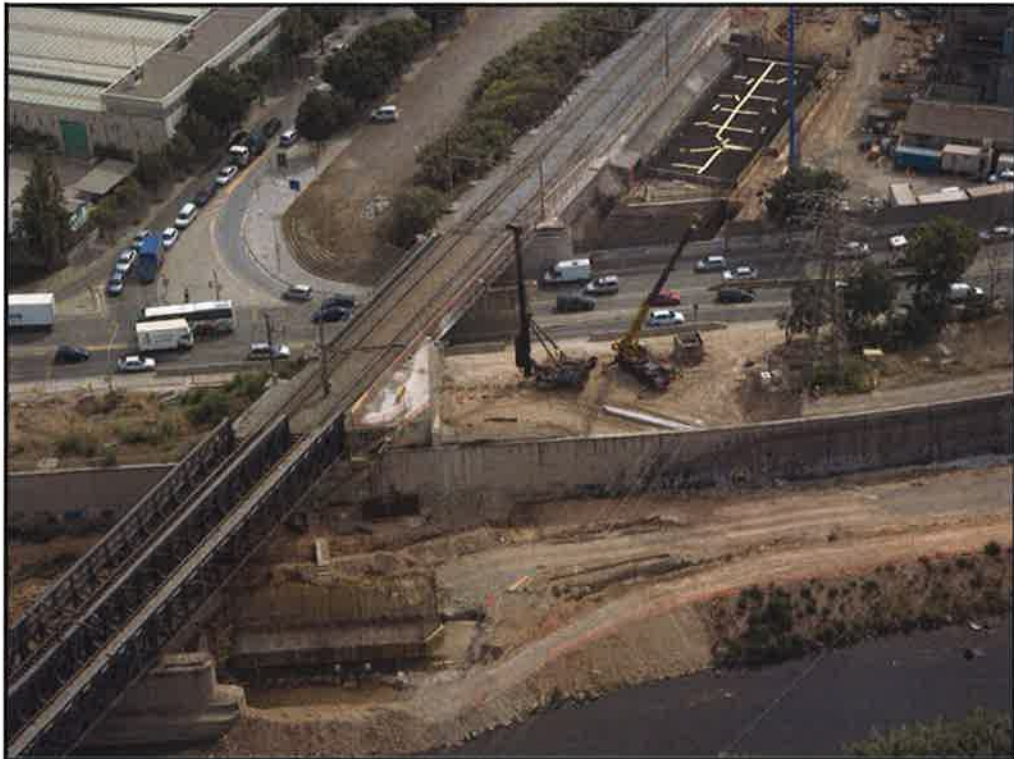
Foto 27. Planta con equipos de ejecución de pilotes hincados en la pila P-1.
