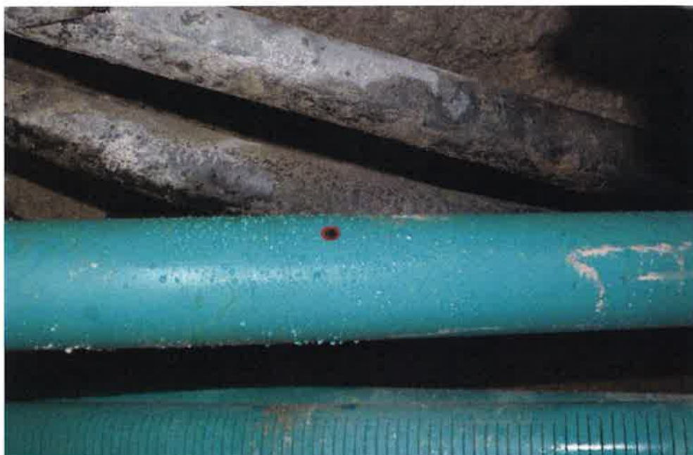
Fotografía nº12: Detalle de tubo de PVC con válvula para inyección de cemento y otro ranurado para drenaje.
