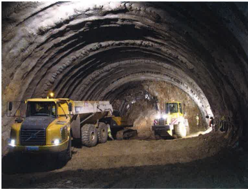
Fotografía n°23: Vista del frente durante la fase de excavación en avance en jabres más competentes.
