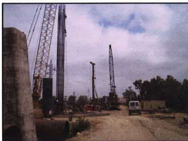
Foto 9 y 10. Excavación de un pilote y colocación de camisas para soldar y de armadura.
