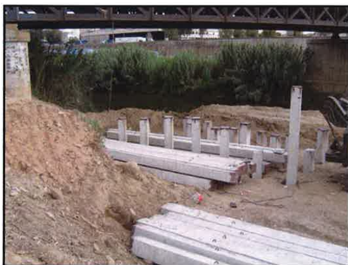
Foto 29, 30 y 31. Pilotes hincados ejecutados y pilotes acopiados a pie de obra.
