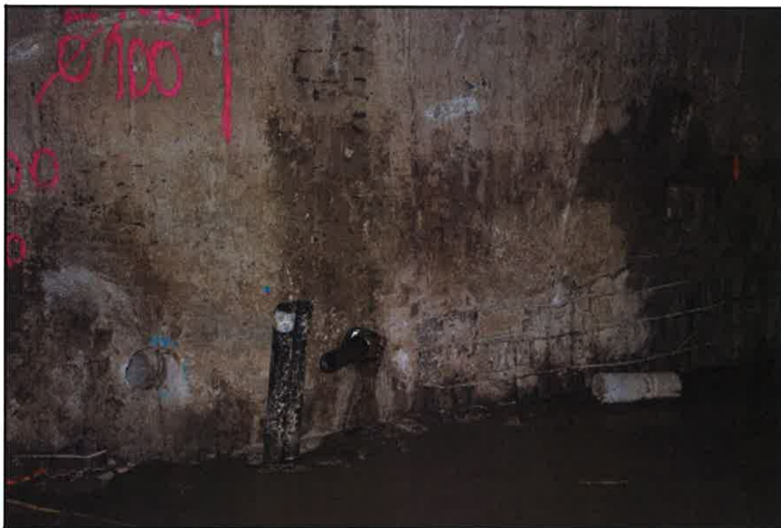
Foto 23. Detalle de la ejecución de drenes horizontales (a la izquierda perforación previa de la pantalla de hormigón y a la derecha instalación de tubo ranurado).
