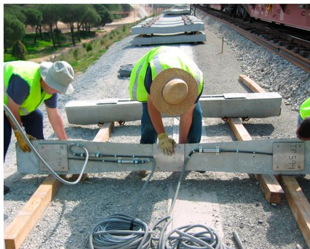
Foto 4. Instalación de células de presión bajo las traviesas.
