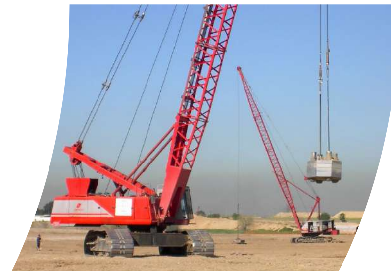
COMPACTACIÓN DINÁMICA PESADA
