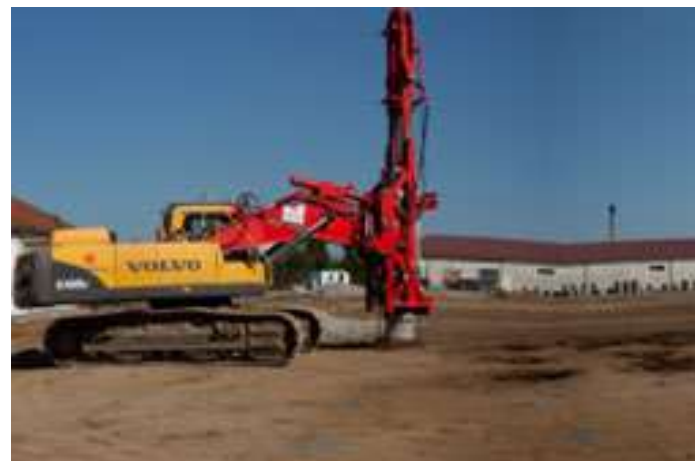
COMPACTACIÓN DINÁMICA LIGERA
